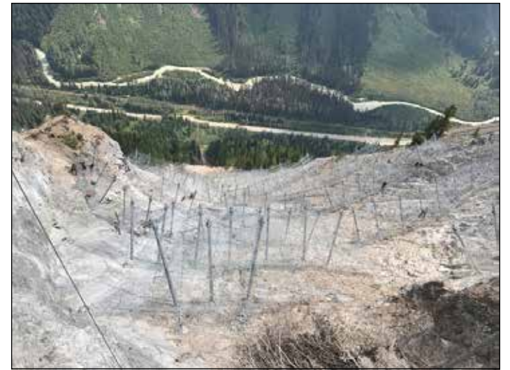
Figure 3 : Des filets pare-neige installés à Cougar Corner, 10 kilomètres à l'ouest du col Rogers (Photo Brian Gould, Alpine Solutions Avalanche Services)
